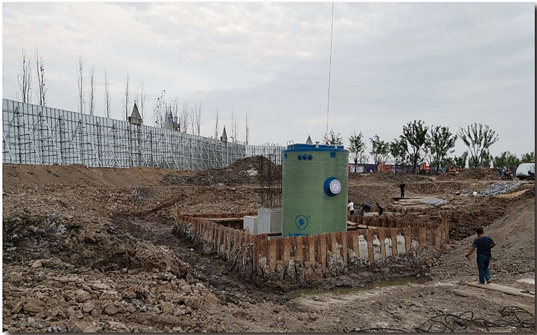
园区污水提升：φ 4200-7200
